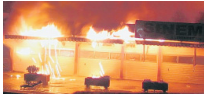
Nicht zu retten: Auch aus dem Inneren des Lebensmittel-Geschäftes schlugen Flammen nach draußen.
